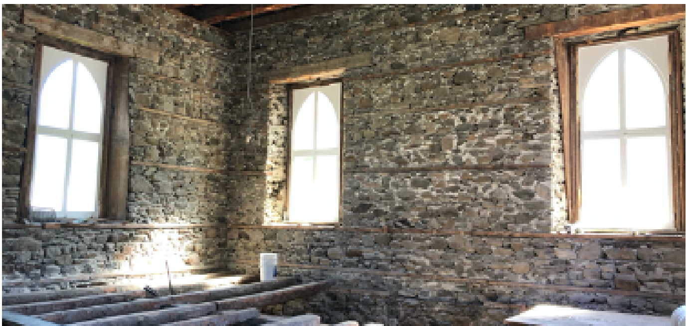
Travaux de mise à nu de l'intérieur de l'église Olivet, 16 août 2022
